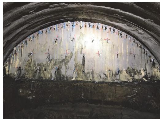
写真-4 軽量鋼管の打設完了状況
